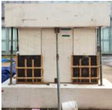
(d) 거푸집 설치 후 콘크리트 타설
