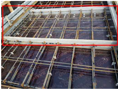
(c) 철판형 비내력벽 연결 시스템 슬릿 거꾸집 제작
