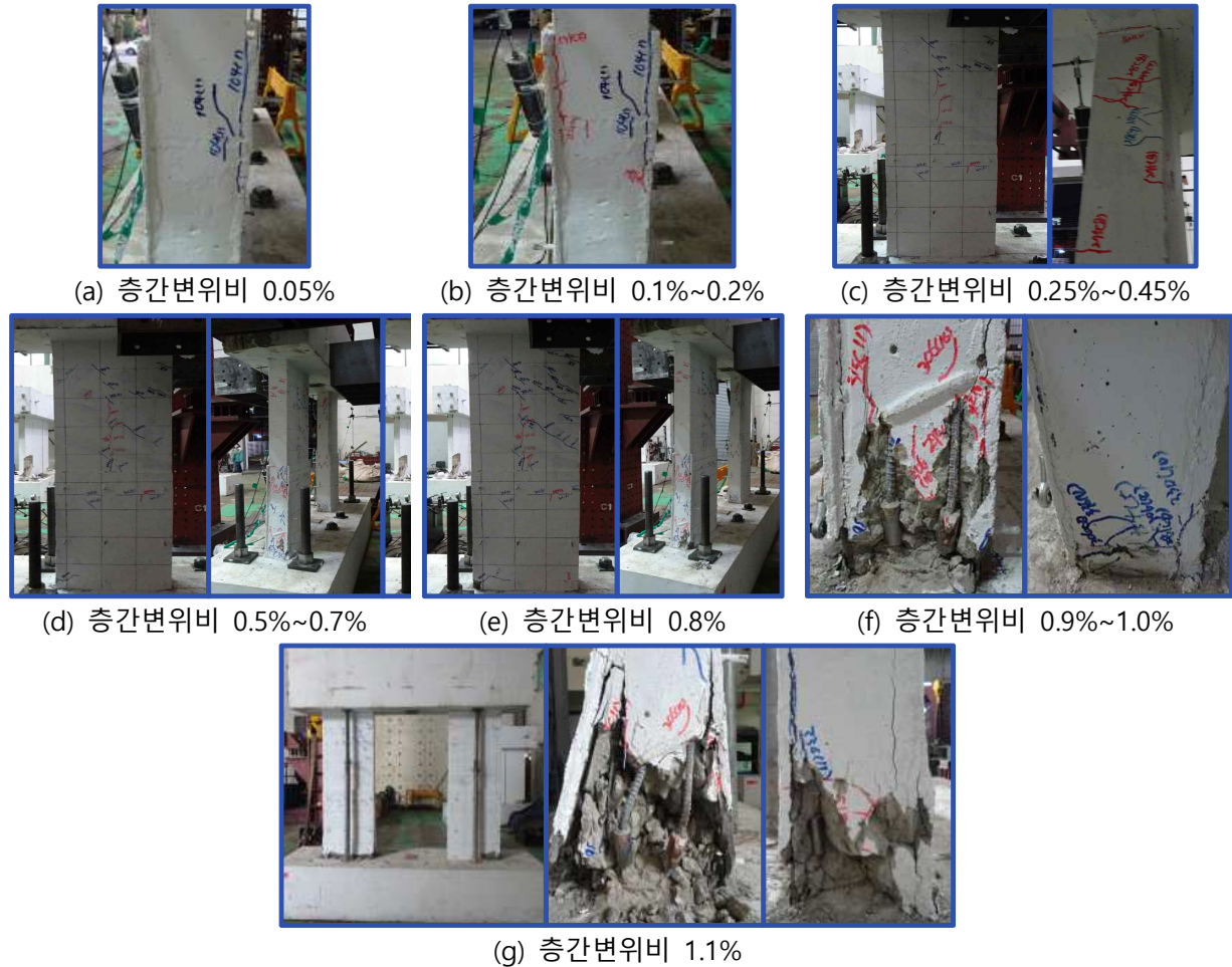
[그림 2.134] PCW_R의 균열 및 파괴 양상
