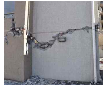
[그림 2.39] 수직 및 수평 비정형성으로 인한 파괴
