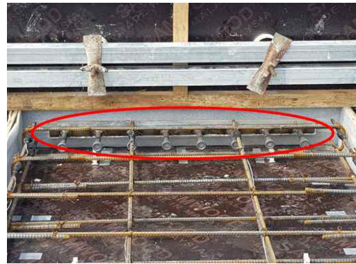
(d) 철판형 비내력벽 연결 시스템 시공
