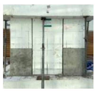
(i) 보수·보강 완료
