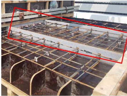
(a) 다월바형 비내력벽 연결 시스템 슬릿 거꾸집 제작
