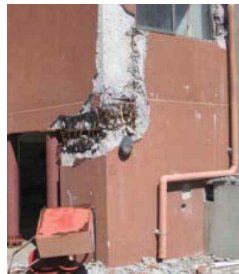
[그림 2.39] 수직 및 수평 비정형성으로 인한 파괴
