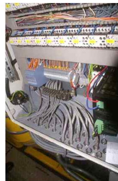
Bild 7: Beispiele niederimpedante Kontaktierung eines Kabelschirms
