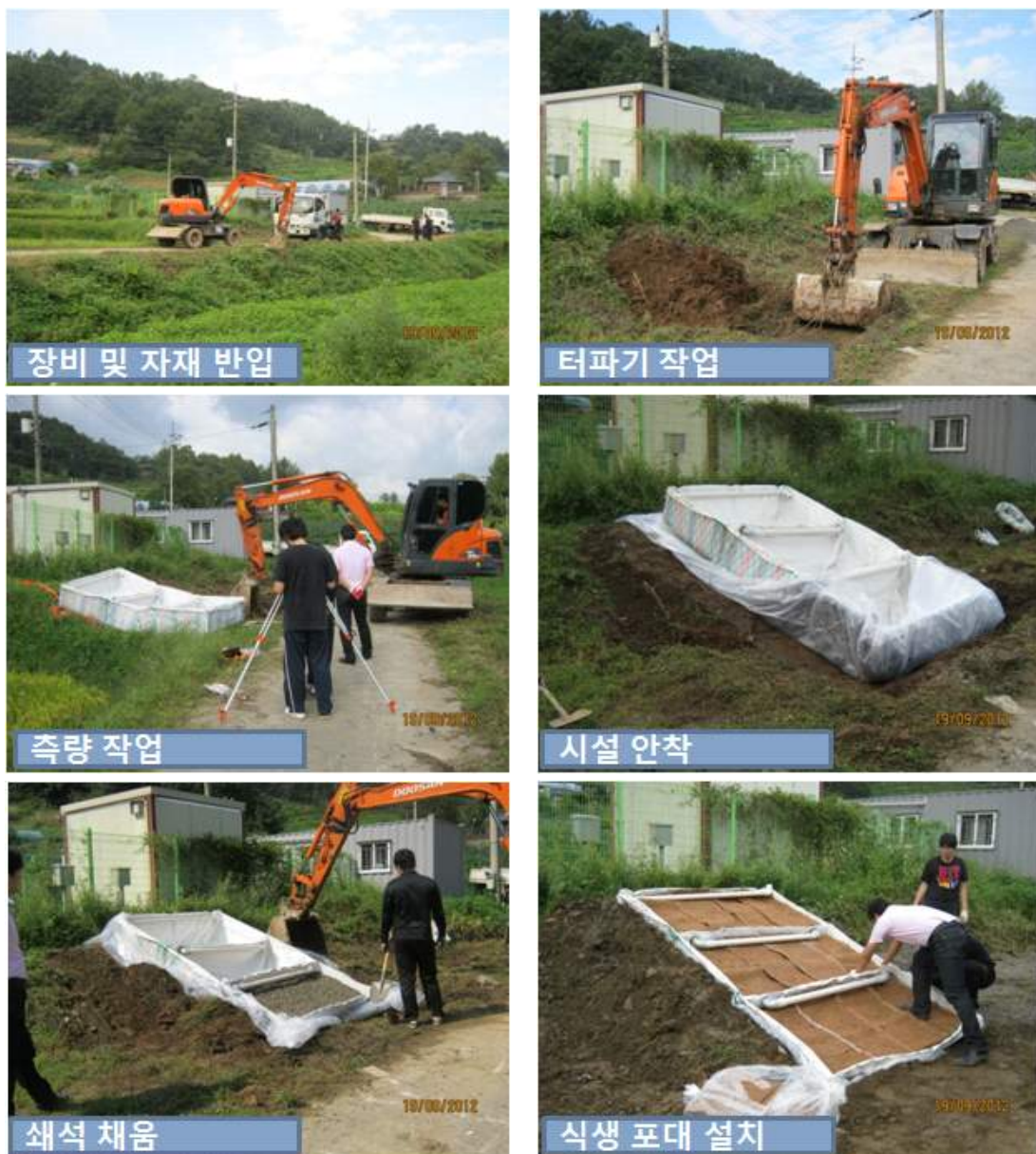
[그림 4-33] 3차 처리 및 비점오염처리 시설 현장 설치
