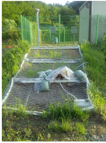
[그림 4-38] 시간 경과에 따른 3차 시설 및 비점오염처리 시설 살수여상(식생조) 변화 과정(pilot plant)
