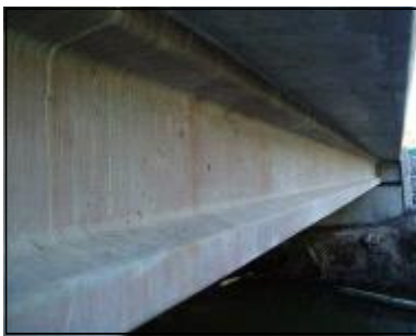
[Sherlly Creek 교량에 거치된 UHPC I형 거더]
