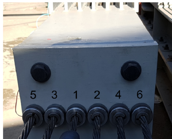
그림 1-7. 모노 스트랜드잭을 이용한 강연선 초기 긴장 순서
