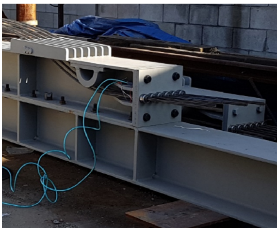
그림 1-7. 모노 스트랜드잭을 이용한 강연선 초기 긴장 순서
