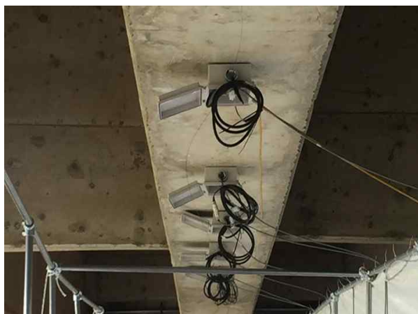
(a) 거더 하단부 센서 설치 1
