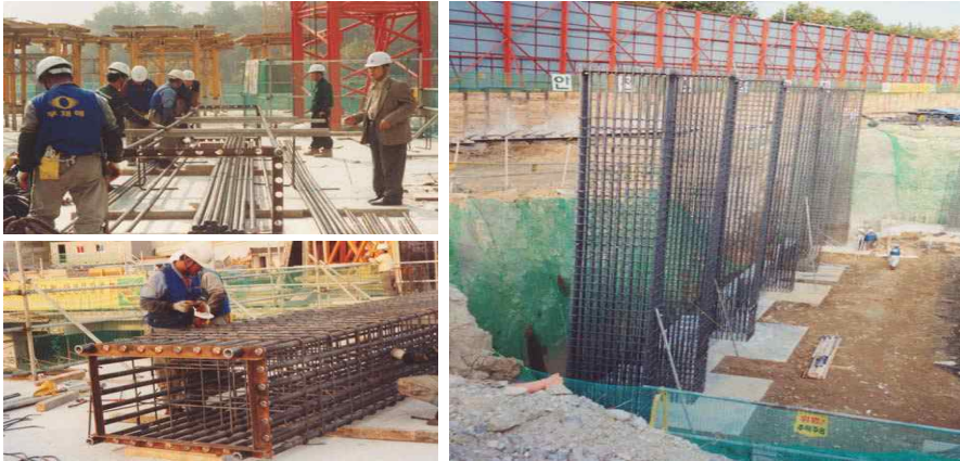
그림 1.4 철근 선조립 공법 시공 사례 (삼성동 H사 아파트 시공현장)
