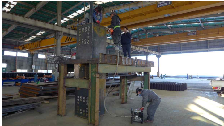
(b) 콘크리트 타설
