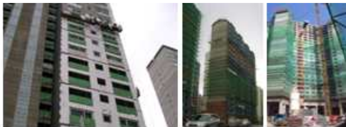
[그림 16] 가설재 설치 및 작업 사진
