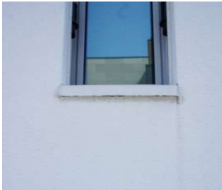
[그림 41] 창호주변 우수로 인한 오염 <출처 : Sto A&C 블로그>
