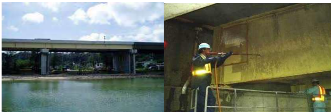
<그림 12. 미세기포 세척장비 Ligaric사와 서일본 고속도로 주식회사 협력하여 고도속도로 교각 구조물 염분세척> : West Nippon Expressway Co., Ltd., Japan.
