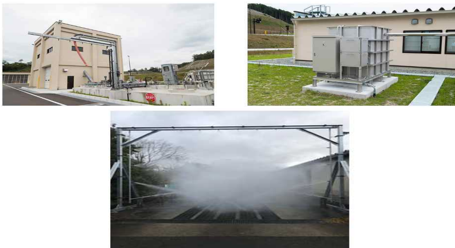
<그림 30. 일본 초미세기포를 이용한 차량용 염분세척 시스템 기지 구축>
