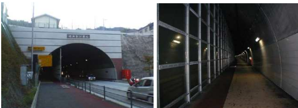
<그림 24. 히카리 터널의 전경(좌) 및 보행자 도로 분리 벽(우)>
