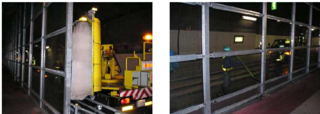
<그림 26. 터널 내 벽면에 대한 스위퍼에 의한 작업(좌) 및 사람에 의한 인력 청소(우)>
