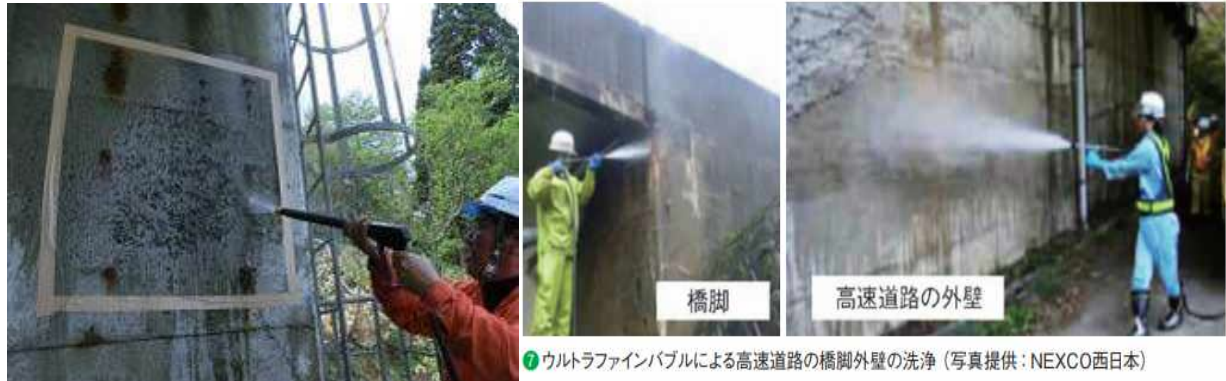
<그림 16. 콘크리트 및 철근부식 정도가 심각한 도로구조물 교각 하부 및 측면 미세기포를 이용한 세척 전경>
