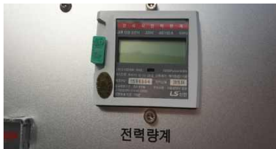
<그림 62. 세척장비 장착된 전력량계 및 유량 전산계>
