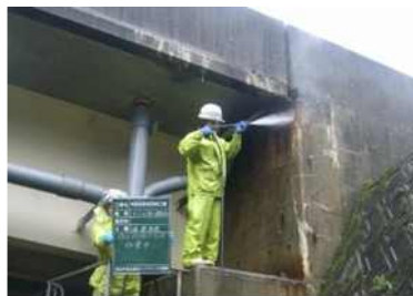
도로 콘크리트 염분 세척
