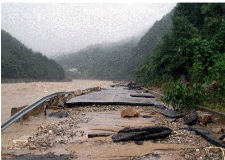
<그림 3-2> 하천범람에 의한 도로피해(강원도 인제군)
