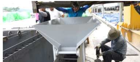
그림 156. 전용 호퍼 형상 및 타설 적용
