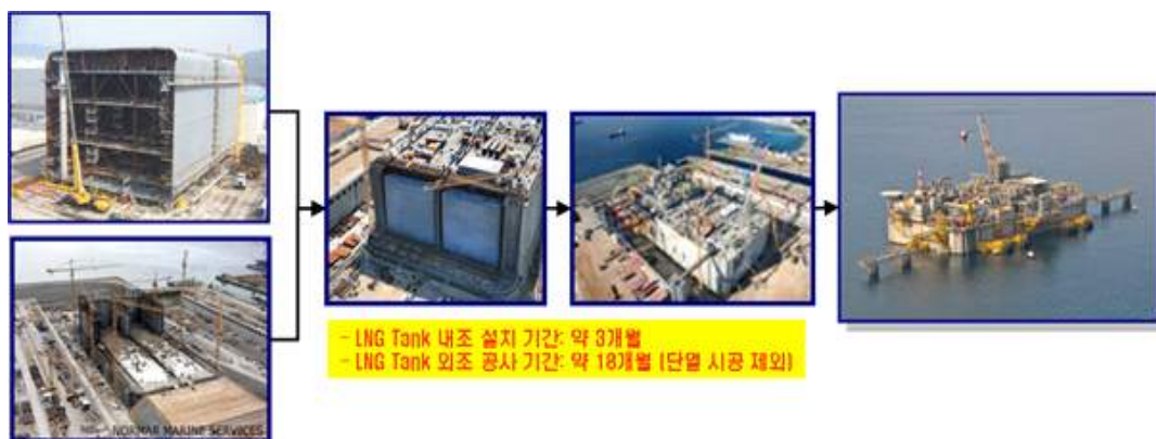
그림 1. Adriatic 해상 LNG Terminal 제작 순서 (※출처 : Exxon Mobil)
