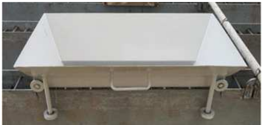
그림 156. 전용 호퍼 형상 및 타설 적용
