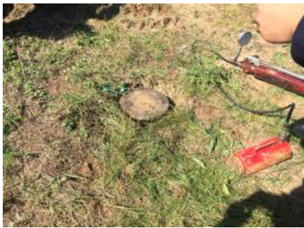
(a) 지압판 설치
