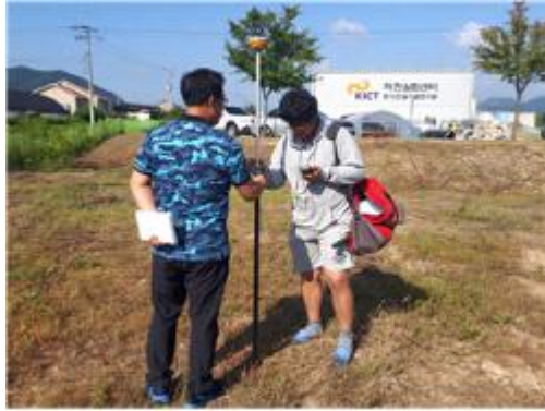
<그림 55> GPS를 이용한 시공위치 측정
