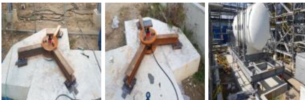
Fig. 4.3 변위 대응형 플랜트 시험체의 현장적용
