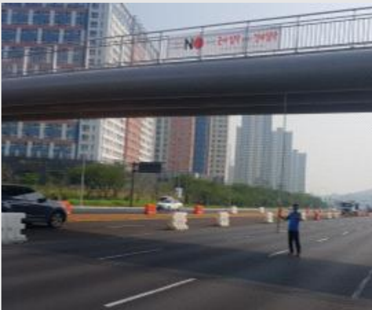
3. 퀸즈파크배곧 육교 H=5.8M
