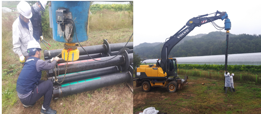
<그림 57>. 시공장비와 말뚝 조립
