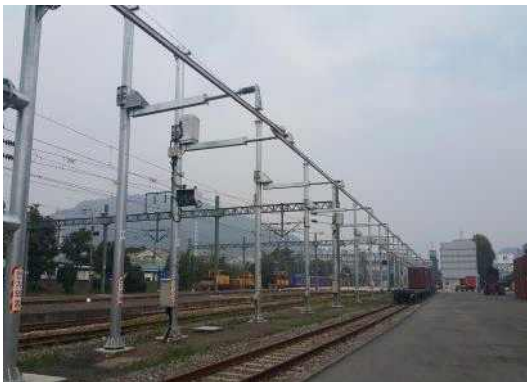
그림 63. 보조제어장치 설치(5개소)
