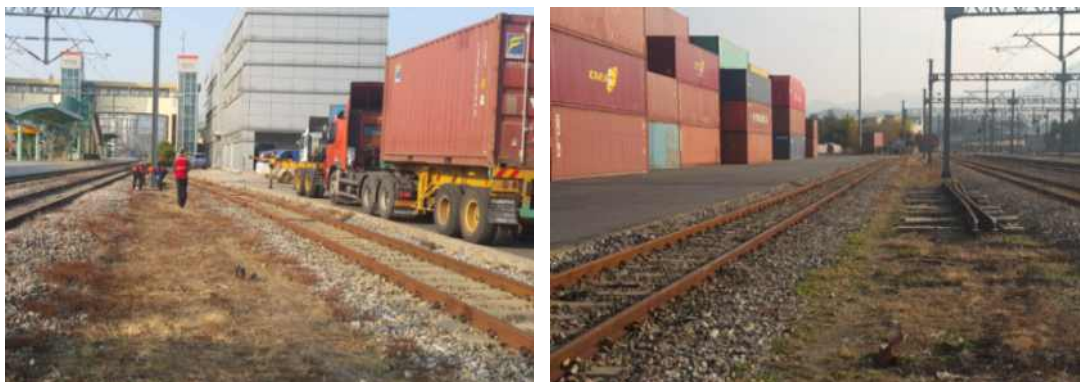
그림 6. 옥천역 현장 전경
