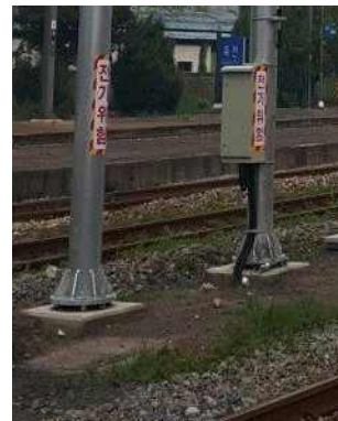
그림 63. 보조제어장치 설치(5개소)
