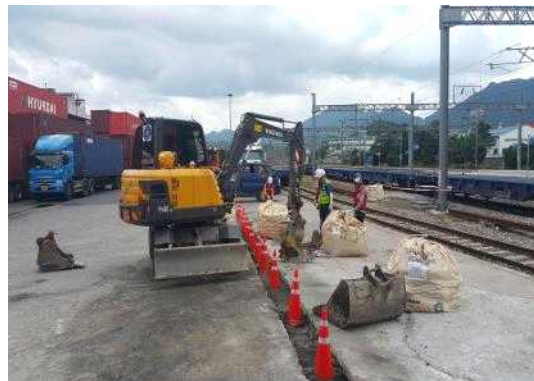
그림 53. 콘크리트 절단시공
