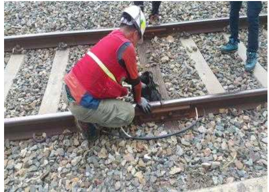
그림 71. 화물취급선(옥천역구내 #1번선) RAIL BONDING 작업
