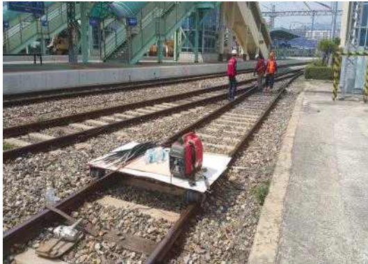
그림 71. 화물취급선(옥천역구내 #1번선) RAIL BONDING 작업
