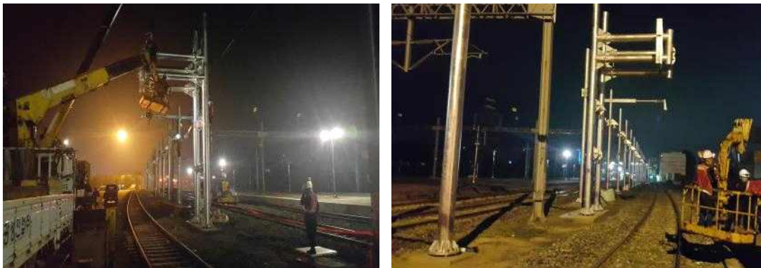
그림 61. 인류장치 전철빔 시공(남북 각1개소)
