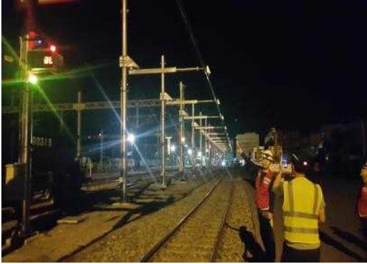
그림 68. 이동식전차선 운전 및 ALIGNMENT 조정
