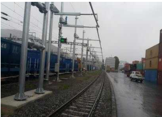
그림 69. 이동식전차선 운전 및 ALIGNMENT 확인
