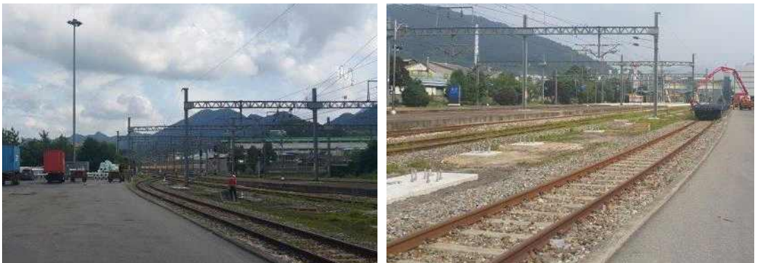
그림 58. 전철주 기초 콘크리트 양생 및 후처리
