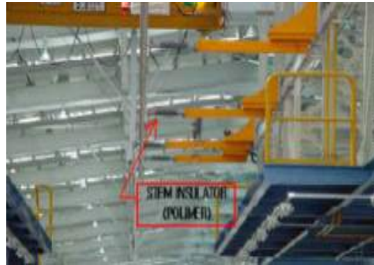
그림 26. 장간애자 설치
