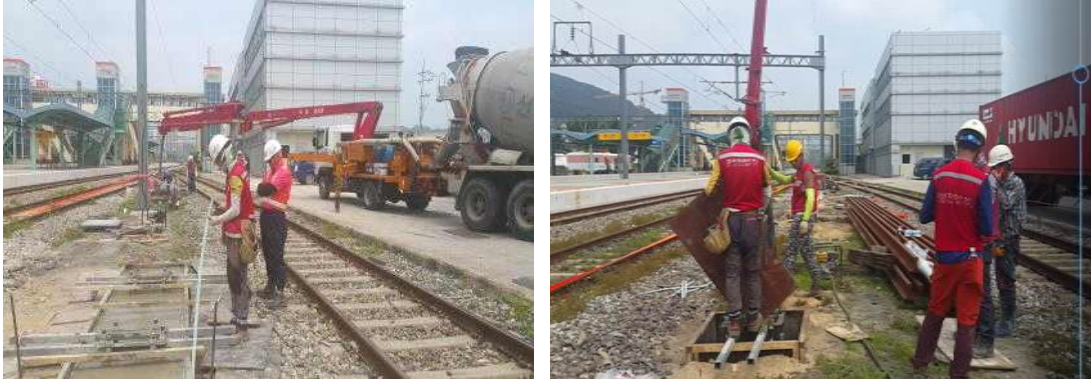
그림 57. 전철주 기초 콘크리트 타설
