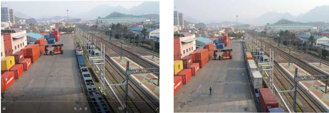
그림 77. 옥천역 화물취급선 이동식전차선 E&S(입환생략모델)운영시험
