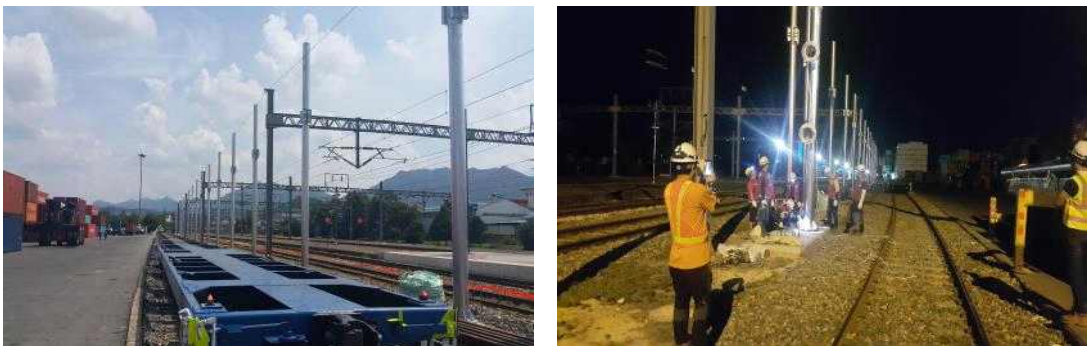
그림 59. 전철주 및 인류철주 시공
