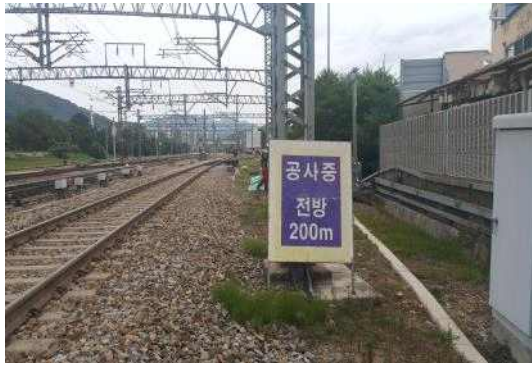
그림 54. 공사중 표지 설치 및 전철주 위치 마킹
