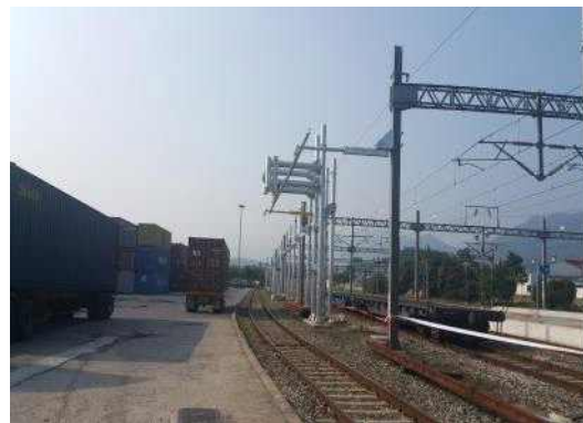
그림 69. 이동식전차선 운전 및 ALIGNMENT 확인
