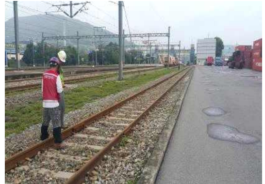
그림 54. 공사중 표지 설치 및 전철주 위치 마킹
