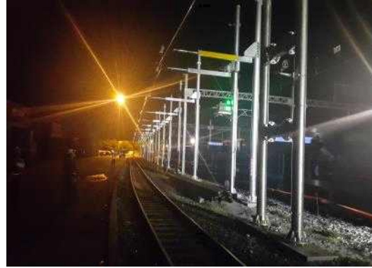
그림 68. 이동식전차선 운전 및 ALIGNMENT 조정
