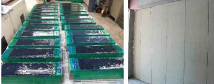
그림 1-3. FRP 및 고성능 시멘트 복합체를 활용한 건식 보강 기법
