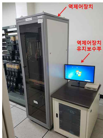
[그림 3-46] 천원역 역제어장치 및 유지보수부 설치
