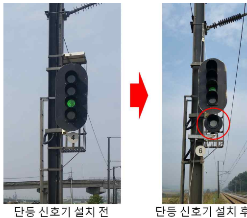
[그림 3-51] 신규 단등 신호기 설치
