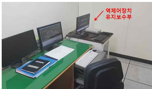
[그림 3-45] 정읍역 역제어장치 유지보수부 설치
