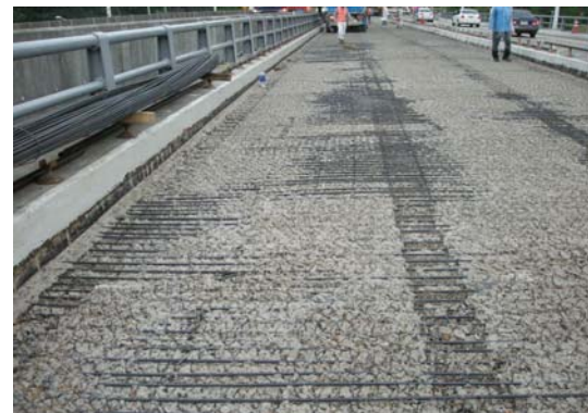
<파쇄 후 상부 콘크리트 면상태>
