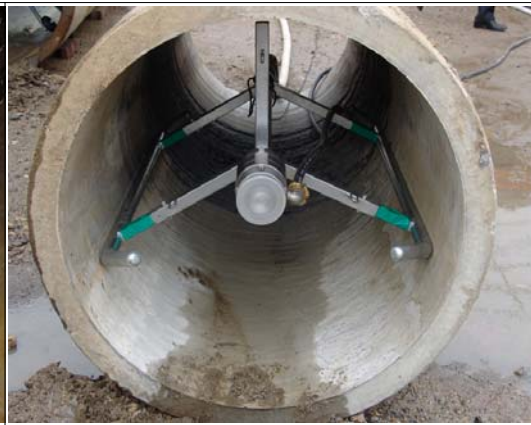
(4) 실 시공장면-뽑어붙이기 모르타르타설장치 설치
