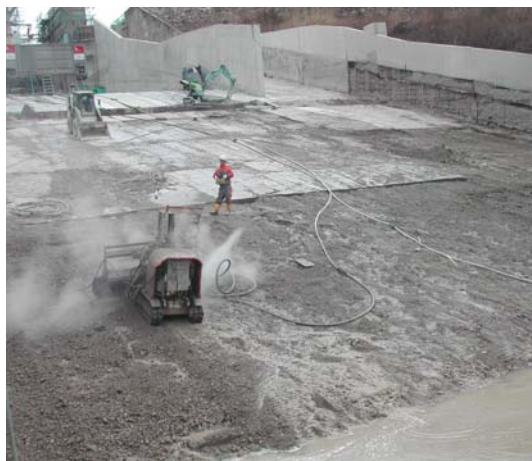
대규모 경사구조물용 Hydro-demolition 자동화 로봇장비 개량
