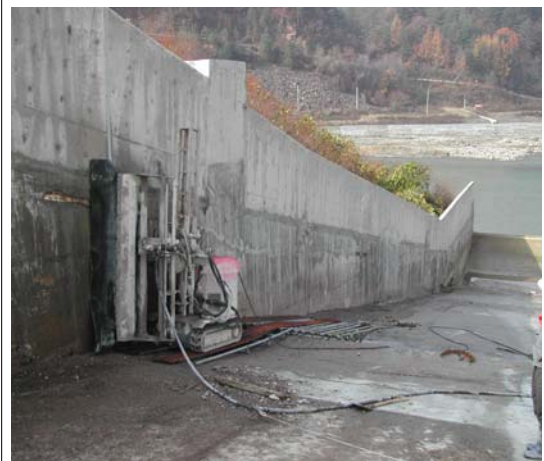
대규모 경사구조물용 Hydro-demolition 자동화 로봇장비 개량
