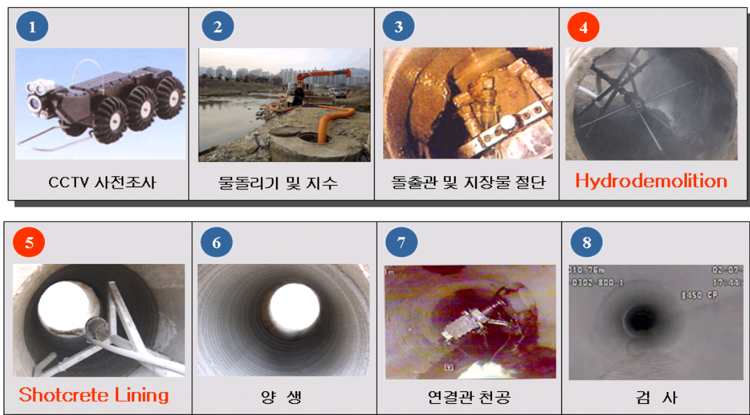
<Hydro-demolition과 Shotcrete Lining 실증화 시스템 공정도>
