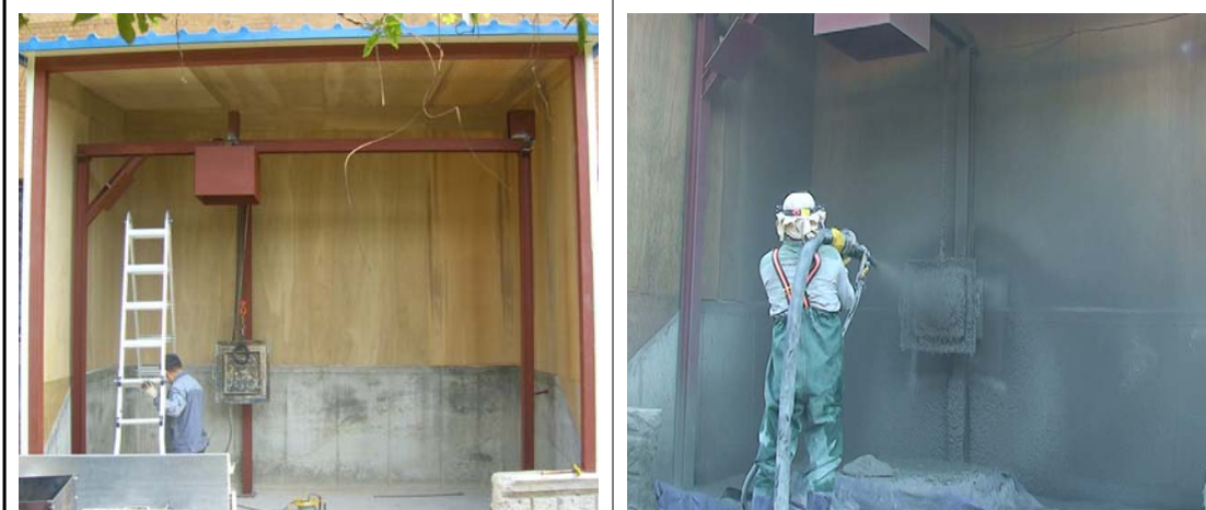
실외 숯크리트 전문연구시설 구축 및 실험
