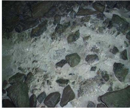
(a) 시공 중 터널 내부 바닥층
