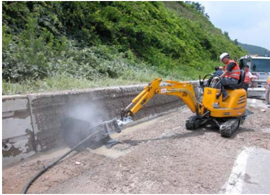
<경사용 자립형 Hydro-demolition 자동화 장비 전경>
