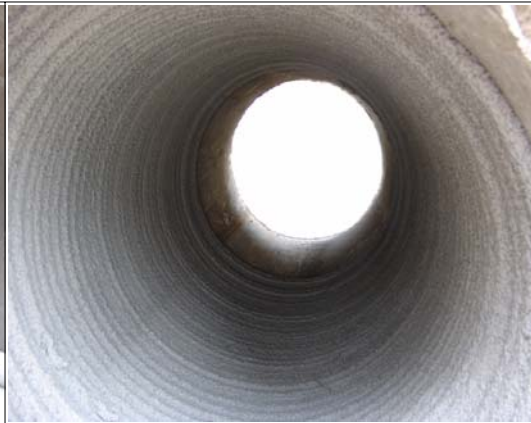
(6) 실 시공장면-시공 후 전경
