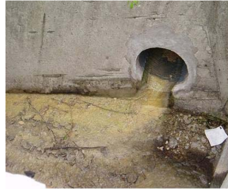
(b) 작업 중 외부 터널 배수로
