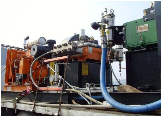
<워터블라스팅 1,400bar 펌프>
