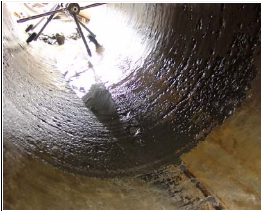
(3) 실 시공장면-가압수에 의한 관로 이물질 제거 완료
