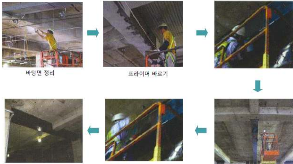
그림 3. 인장부 FRP 보강 시공 절차.
