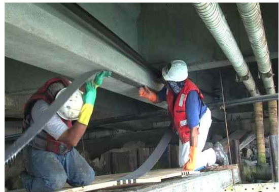
그림 2. 인장부 FRP 보강 시공.
