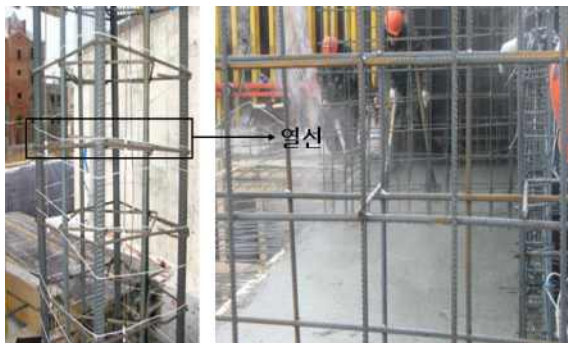
그림 1.2 하바로브스키 신축공사 - 영하 20^{\circ}\text{C} 에서의 열선 설치 및 타설 (콘크리트학회지, 2009.03)
