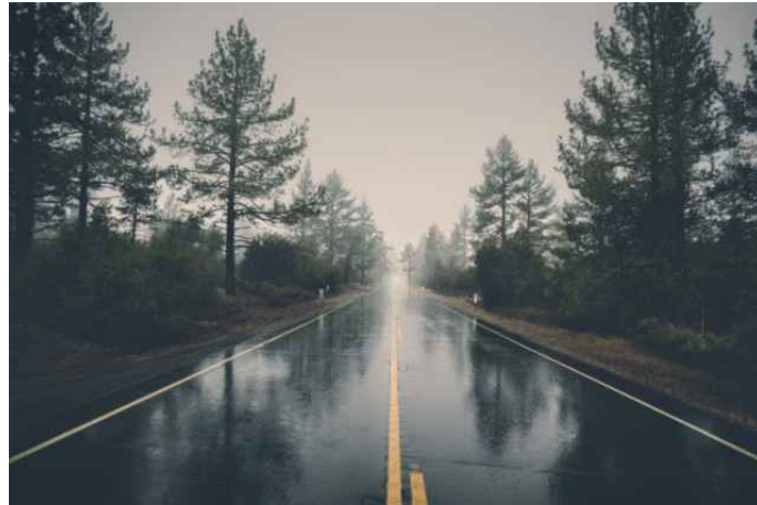
<도로 표면 위 유리막처럼 코팅된 블랙아이스>
