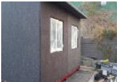
⑧ 마감재 시공 완료
