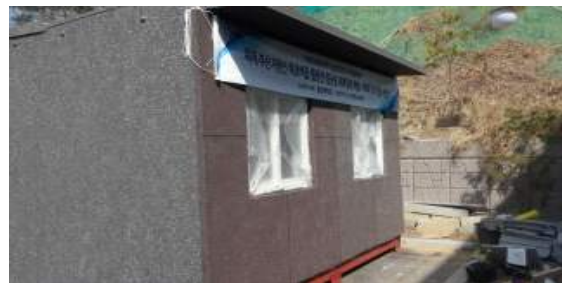
⑦ 외단열 시공완료
