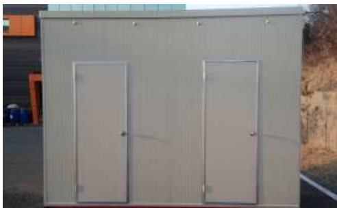
⑤ 문 설치
