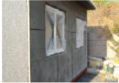
⑤ 몰탈 시공 완료
