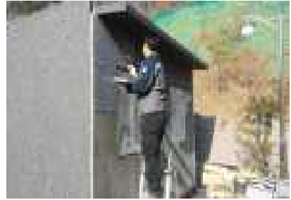
⑥ 마감재 시공
