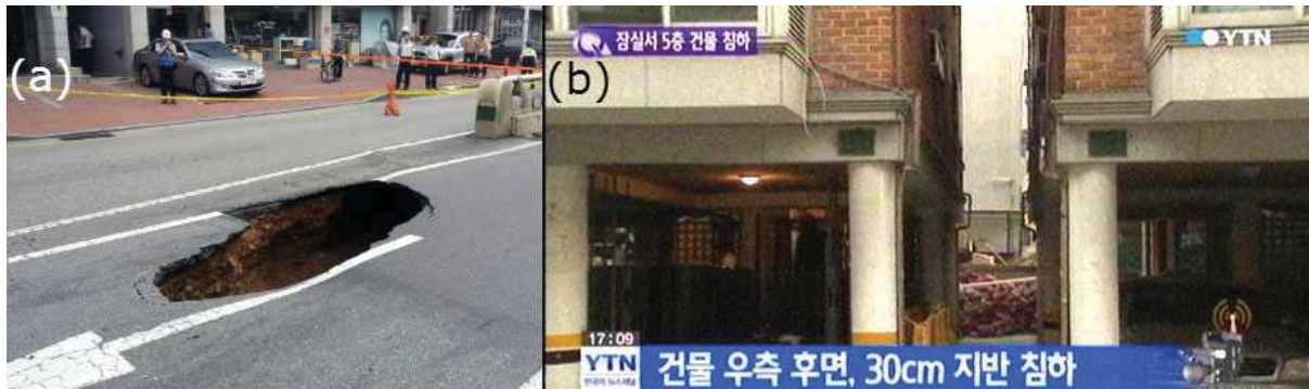
[그림 1.9] (a) 지하철 공사로 인해 발생한 지하차도 침하로 인한 도로 손실; (b) 인근 대규모 터파기 공사로 인한 건물 침하
