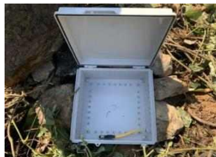
⑧ TDR 센서 보호 함체 설치
