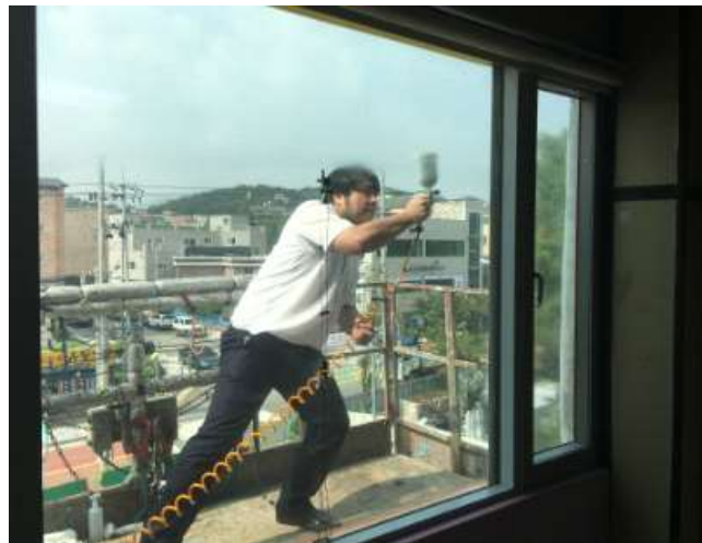
<그림 3-73> 적외선 코팅유리 시공 모습
