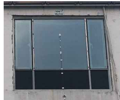
b) 테스트베드 창호부 전경
