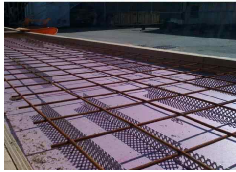
[그림 2.5] 공학목재 바닥구조시스템의 합성작용을 위한 전단스터드 및 상부 철근배근의 예
