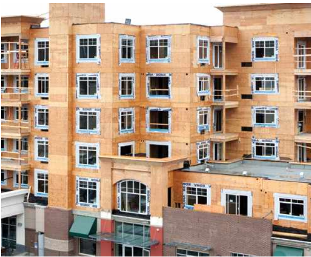
(a) 콘크리트 구조체 상부에 증축된 5층 주거용 목조건축물(캐나다, 밴쿠버)
