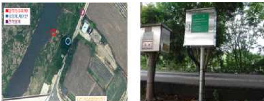
그림 82. 남봉(신기)양수장 전자유량계,수위계,펌프가동식 시스템 설치
