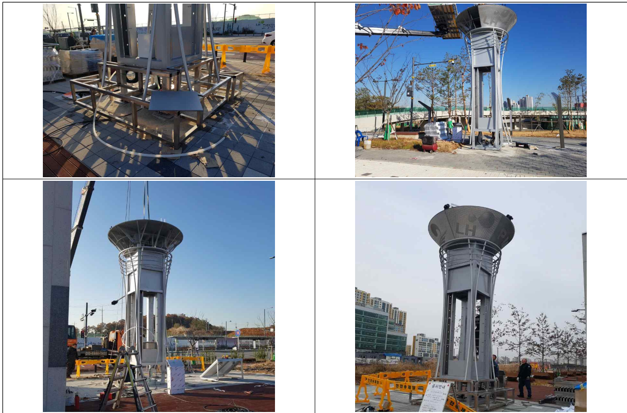
[그림 2-53] 성능개선 미세먼지 저감장치 제작 및 설치
