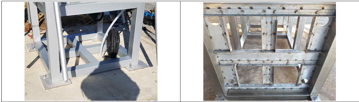
[그림 2-47] 콘크리트 타설 및 용접부 강화
