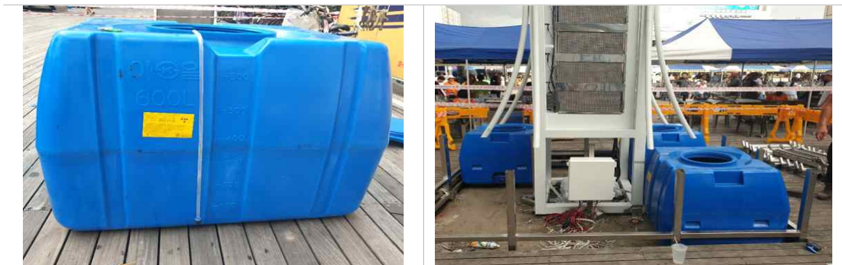
[그림 2-70] 관수시설(600L 물탱크 설치)
