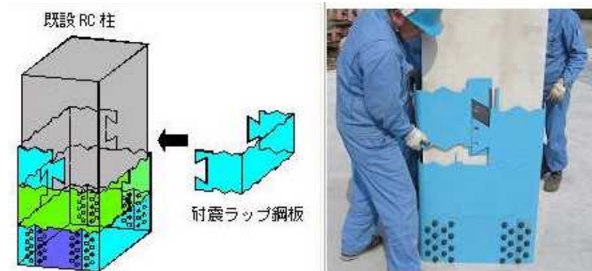
<그림 2.8> 내진 랩 공법의 개요도 및 시공사진
