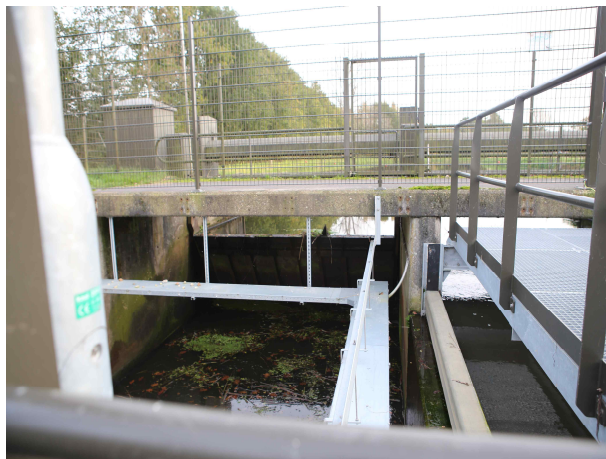
독일 가동보 설치 현장 견학
