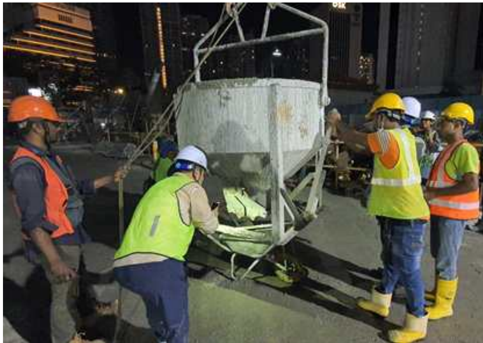
[그림 2.26] 펌핑 후 콘크리트 채취
