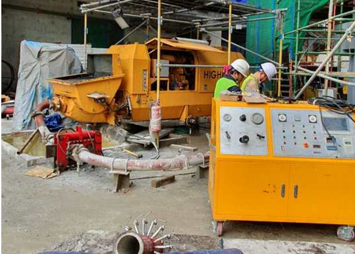
[그림 2.24] 약액주입장치 설치
