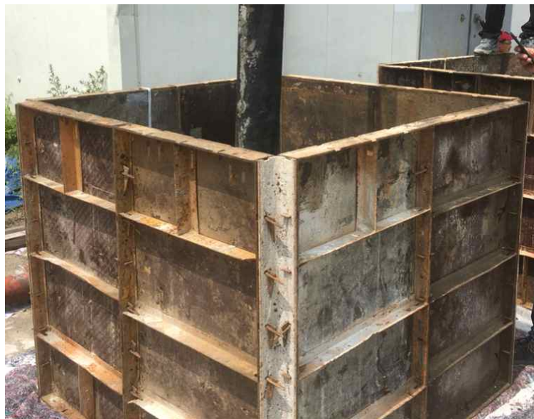
[그림 2.12] 사각 박스를 이용한 콘크리트의 토출량 측정
