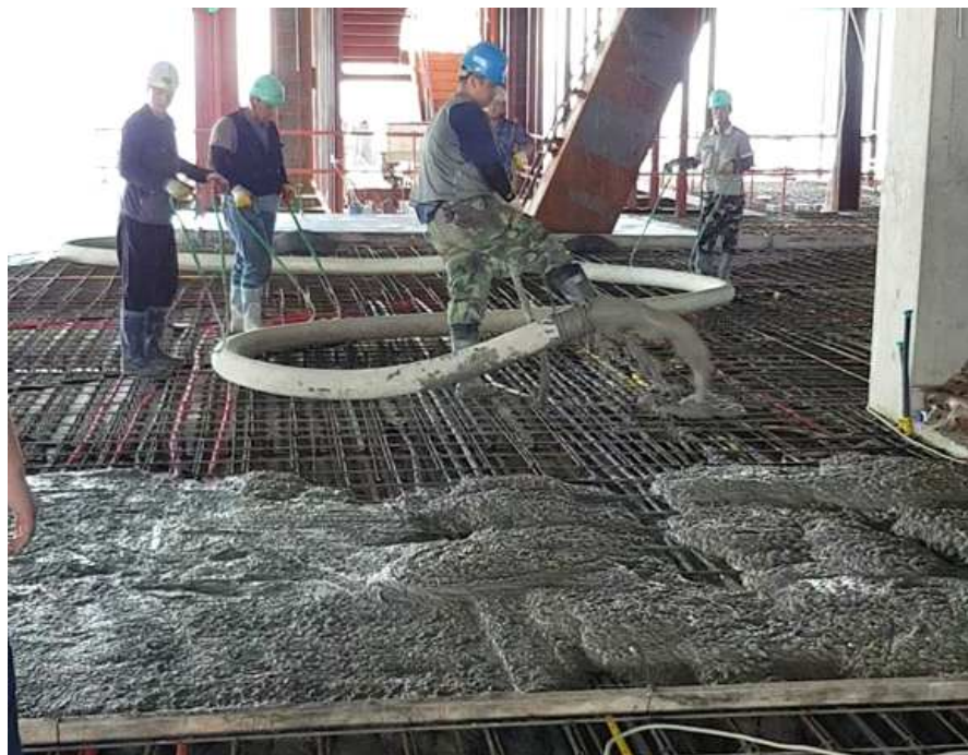
[그림 2.19] 윤활층 활성화제 주입에 의한 토출 콘크리트의 작업성 확보
