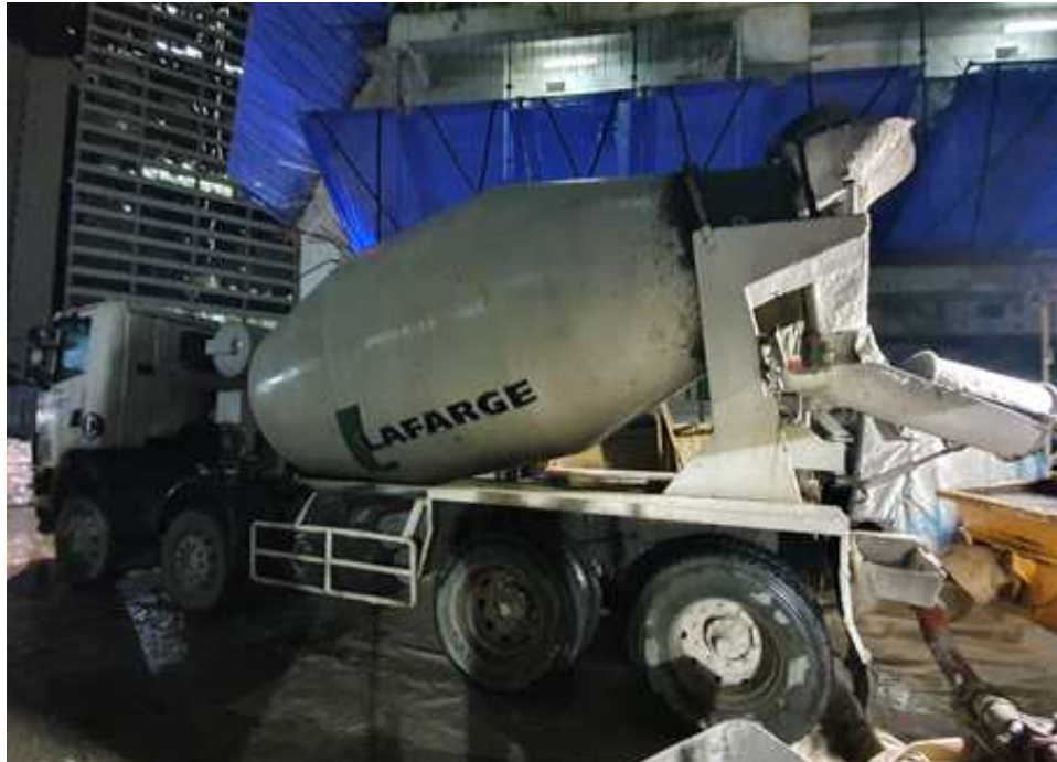
[그림 2.25] 펌핑 전 콘크리트 채취
