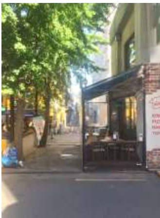
부설주차장 불법점유 (무단용도변경, 무단증축 등)
