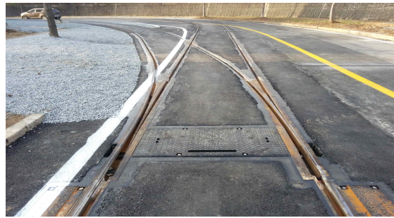
<그림 2-60> ERS궤도 구조 및 현장사진
