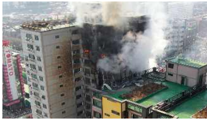
(a) 외벽 단열재로 인한 화재 확산
