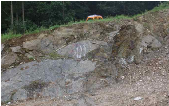
그림 2.55 Construction of model slope
