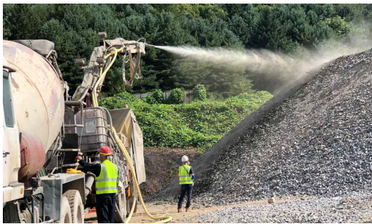
그림 2.16 Shotcrete spraying
