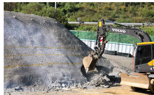
그림 2.19 Excavating model slope
