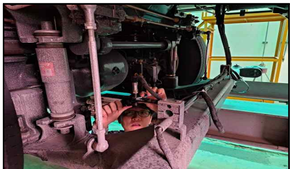
정위치 센서브라켓 교체 작업
