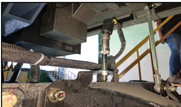
정위치 센서브라켓 교체 작업
