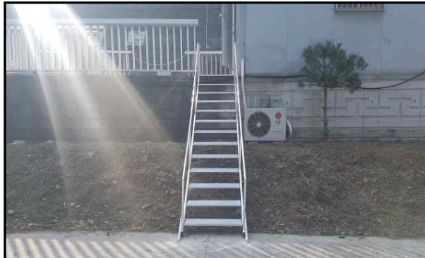
신호기계실 ~ 현장사무실 계단 설치
