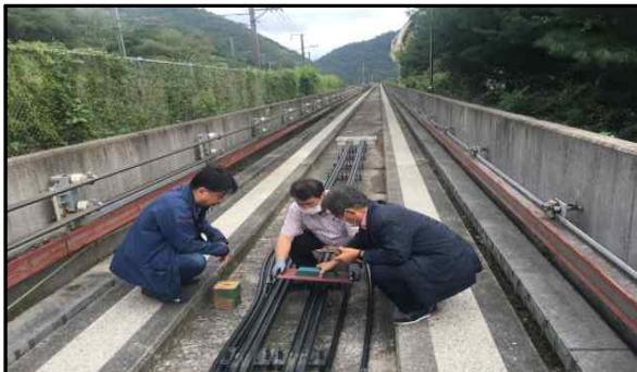
무선급전케이블 이설 작업(미래역)
