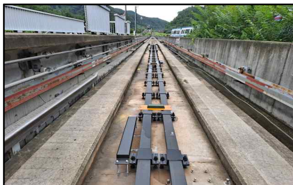
정위치 정차판 및 태그 설치(갯바위역)
