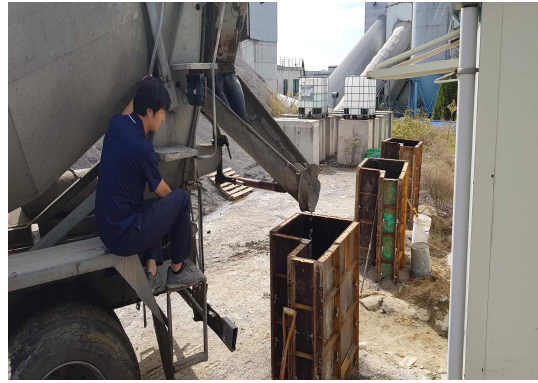
b) 순환골재 콘크리트 타설
