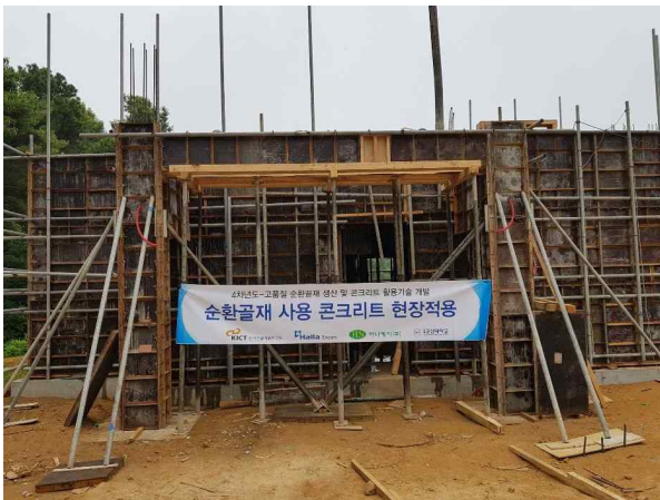
a) 시범적용 현장 1층 타설 (1)
