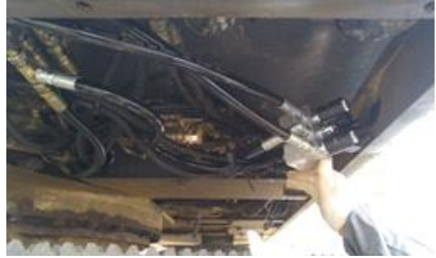
<SOL 밸브, 블록 설치>
