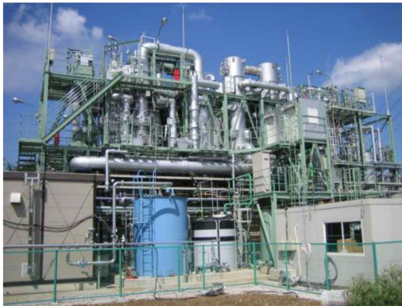
[그림 2-18] 15톤/일급 슬러지 유동층 가스화/전기생산 실증설비 모습
