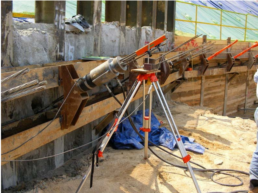
<로드셀을 이용하는 어스앵커 적용 모습>
