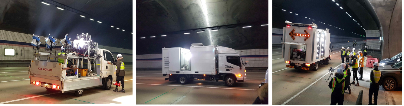
[그림 2-65] 차량 탑재형 터널스캐너 점검(KMTL, 아워브레인, 딥인스펙션/SQ)
