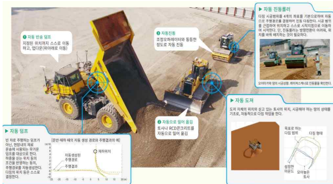
<A4CSEL 시스템 기반 토사반입 및 성토작업 자동화>
