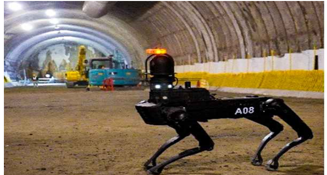
<건설 토목공사 '스팟' 로봇 도입>
