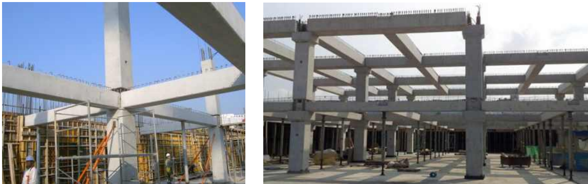
그림 2.1.1 PC구조시스템 시공상황
