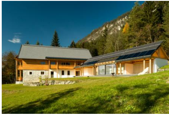
그림 98. Der Weber Haus (목조 리모델링 패시브 하우스)
