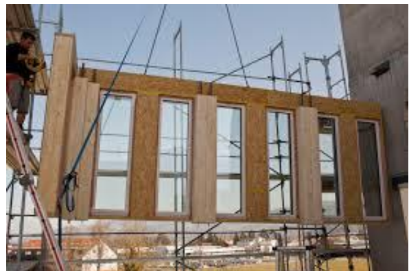
그림 97. LCT ONE (목재 프리패브 파사드 시공)
