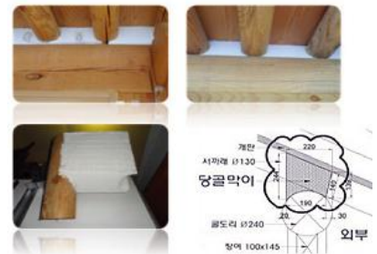
그림 71. 마그네슘 CRC 보드를 활용한 당글막이 열관류율 0.15kWh/m 2 K
