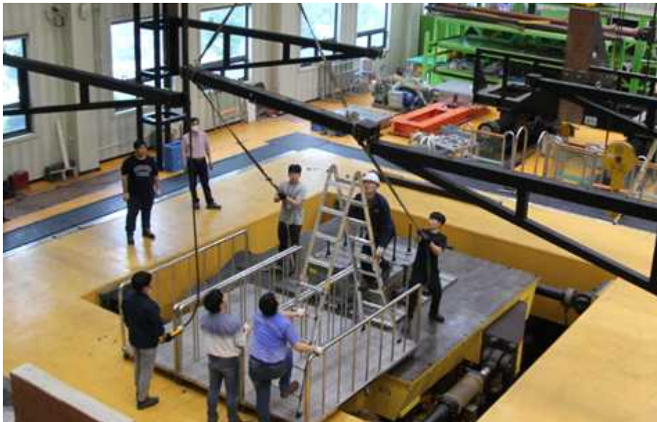
그림 2.80 Reference Frame 설치
