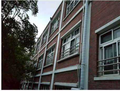
(a) 도포 전 전경
