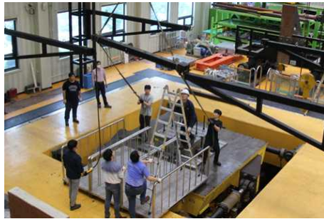
(c) Reference Frame 설치
