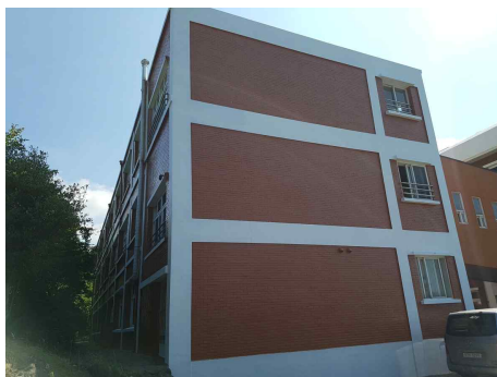
(e) 도포 후 전경
