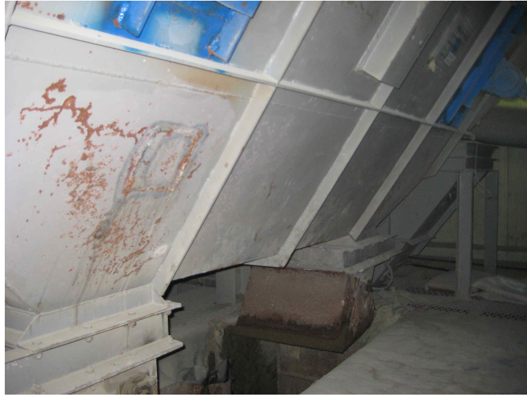
그림 3.4.48 표면수율 측정센서 설치 호퍼
