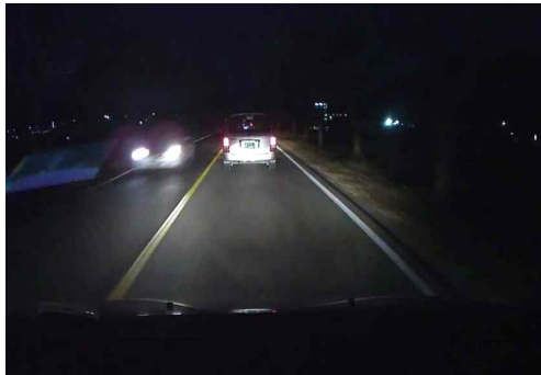
기존 이면도로 상황 (가로등 없음)
