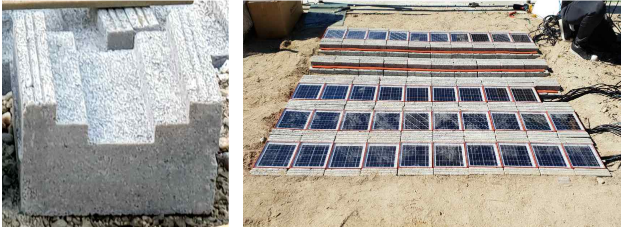
[그림 3] 콘크리트 블록 및 태양광 패널 모듈 시제품 제작 및 설치
