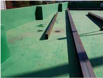
[ 하부 빔 설치 ]
