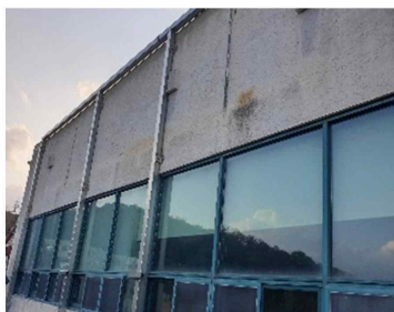
<벽체고정 철물 설치>
