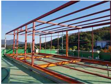
[ 기둥 및 지붕틀 설치완료 ]
