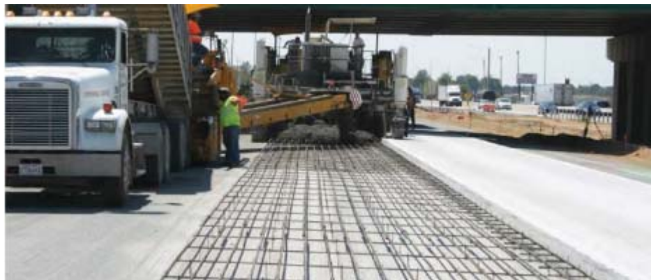
<기존 CRCP 포장의 공사 구간 점용 방식>
