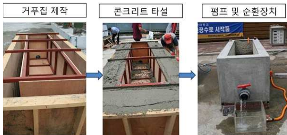
<그림 3.50> 인공수로 제작과정 및 제작완성 후 모습
