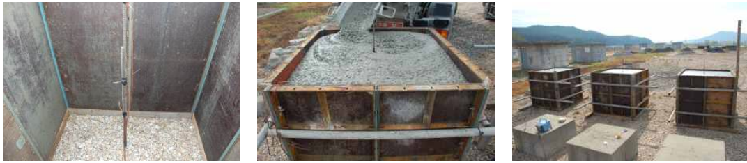
열전대 매설 및 콘크리트 타설
