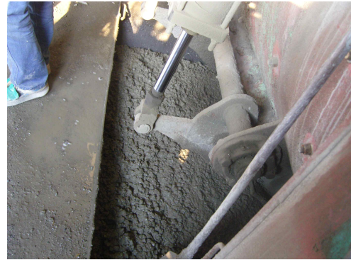
< 그림 3.73 > 콘크리트 혼합
