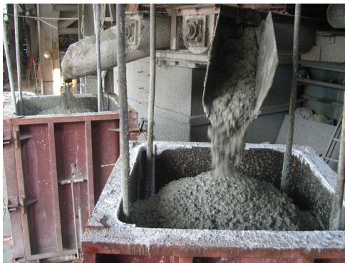
< 그림 3.74 > 콘크리트 타설
