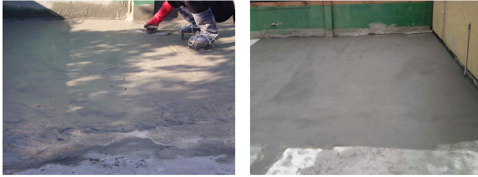
< 그림 3.70 > 모르타르 표면 마감 및 타설 후 사진
