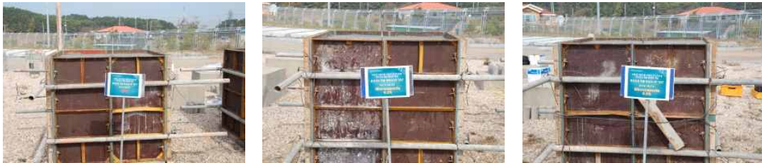
콘크리트 타설 완료
