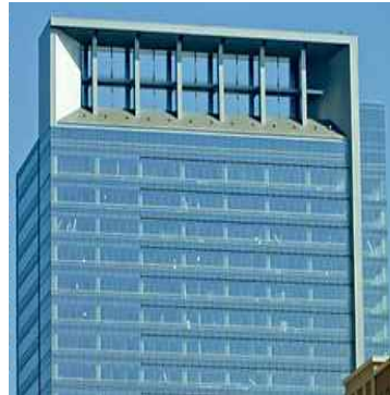
<그림 9> 디스커버리 타워 발전설비
