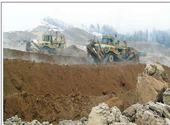
산업단지 부지조성 공사
